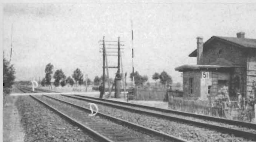
Graniczny przejazd kolejowy w okolicach wsi Kąty
