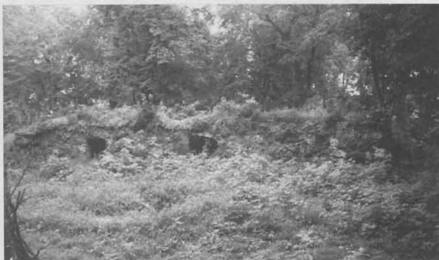
Ruiny zameczku: przyziemia budynku z piwnicami – stan z roku 1996. Fot. W. Mielewczyk
