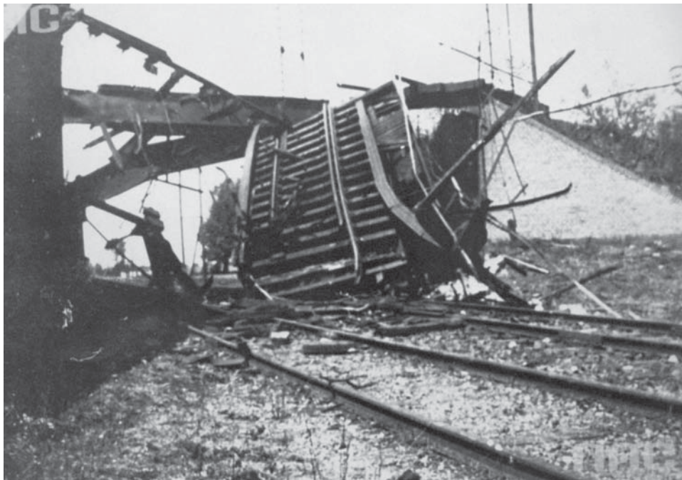
23. Zniszczony przez Niemców wiadukt kolejowy pod Leszmem, 6/7 czerwca 1919 r. NAC, Koncern Ilustrowany Kurier Codzienny, sygn. 1-G-3216
